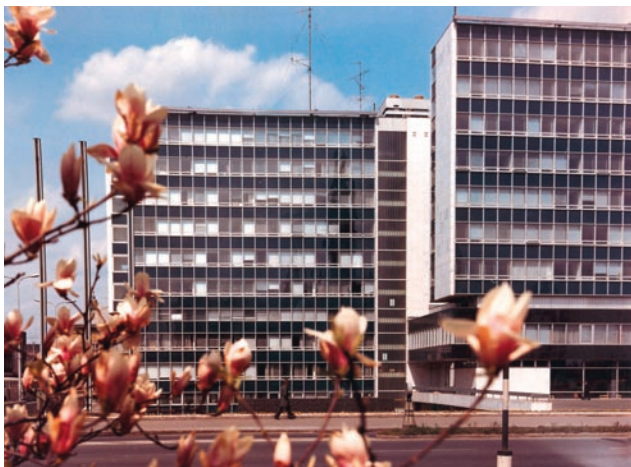
1. kép. Győr típusú ablakokkal készült épület (Győr városközpont)
